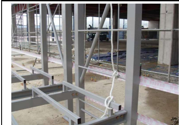
Rack 1번지 라티스 안쪽에 승강 사다리 부착(영구적)
