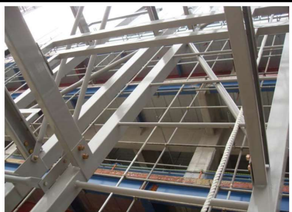
Rack 설치완료까지 Top hat 이동(승강로 확보), Rack 설치 작업 완료후 T/p 원위치
