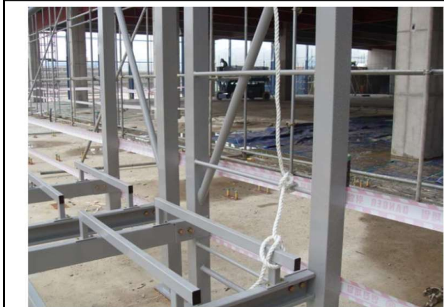
Rack 1번지 라티스 안쪽에 승강 사다리 부착(영구적)
