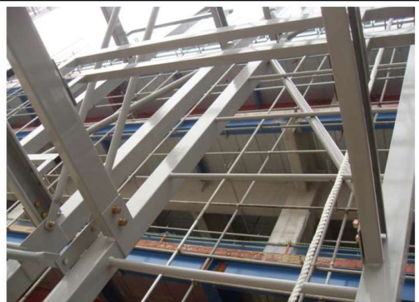
Rack 설치완료까지 Top hat 이동(승강로 확보), Rack 설치 작업 완료후 T/p 원위치
