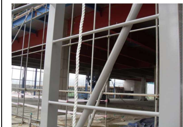
Rack 1번지 열 라티스 안쪽에 승강 사다리 부착(영구적)
