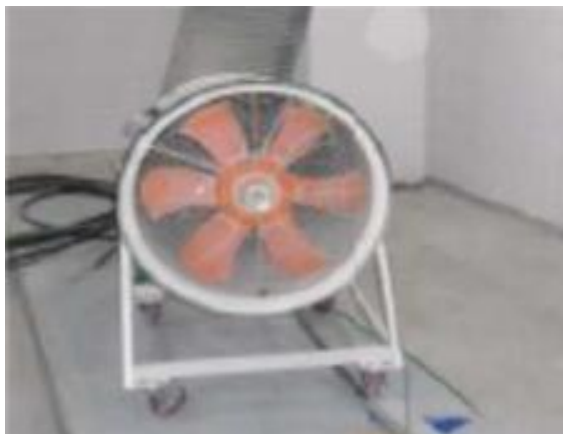
환기시설 송풍기 설치
