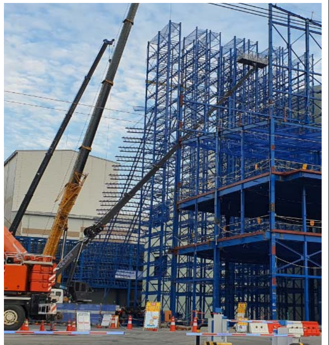
RACK 조립 및 설치 (고소작업차)
