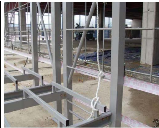
RACK 안쪽 승강 사다리 부착(영구)
