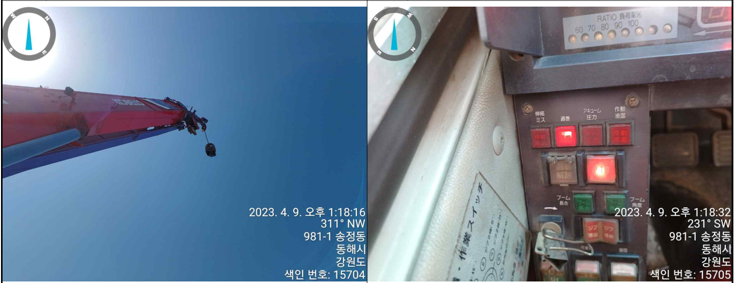
27 메인 권과방지 작동상태 확인 28 메인 권과방지 작동상태 확인(과권적색램프점등)
