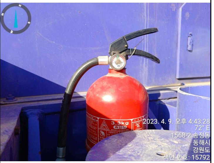
10 소화기비치 및 상태확인 2023. 4. 9. 오후 4:43:28 72° E 1568-2 송정동 동해시 강원도 색인 번호: 15792
