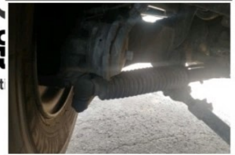
24 1축 조향실린더 상태 확인
