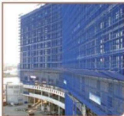
위험을 방지할 수 있는 망을 설치한 경우 발끝막이판 설치 제외
