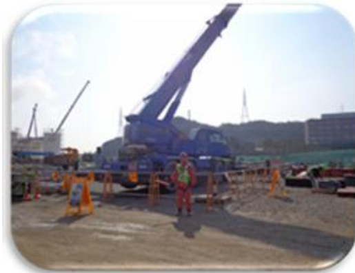
A형 안전난간대 이용 차단시설
