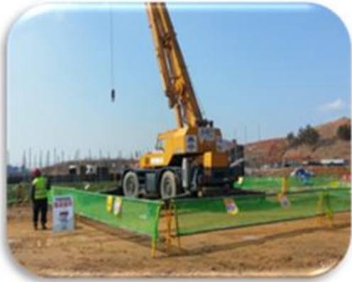
A형 안전난간대 이용 차단시설
