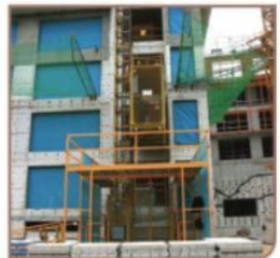
위험을 방지할 수 있는 망을 설치한 경우 발끝막이판 설치 제외
