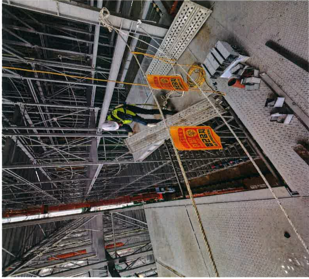
KT&G 광주 공장 자동화 창고 증축 공사 Deck 2F SC 통로 개구부 가설발판 설치 완료
