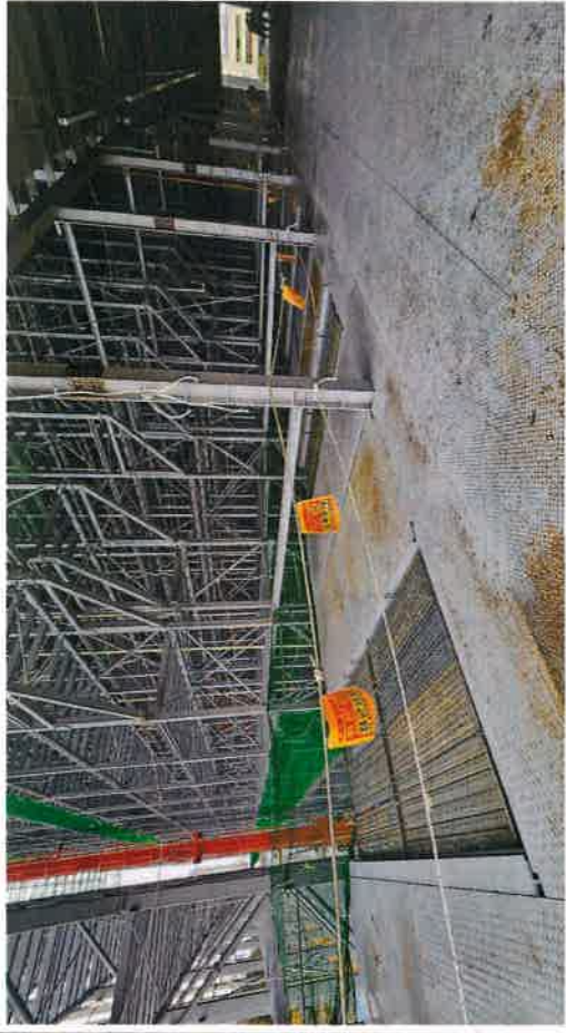
KT&G 광주 공장 자동화 창고 증축 공사 Deck 2F SC 통로 개구부 가설발판 설치 완료
