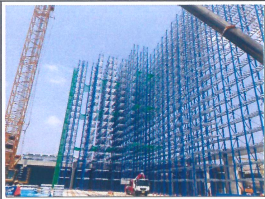
RACK 추락방지망 설치
